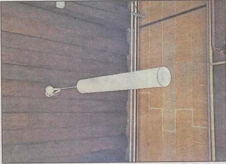
Eine Deckenleuchte wurde probeweise installiert. FOTO: KOLB/FREI
